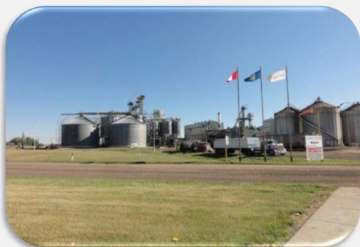
供應商倉儲設備
